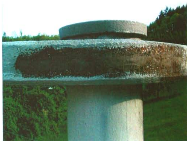
Bild 1: Starke Korrosionsschäden an Schalungsnaht
