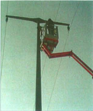
Bild 6: Belüftung der Masten
