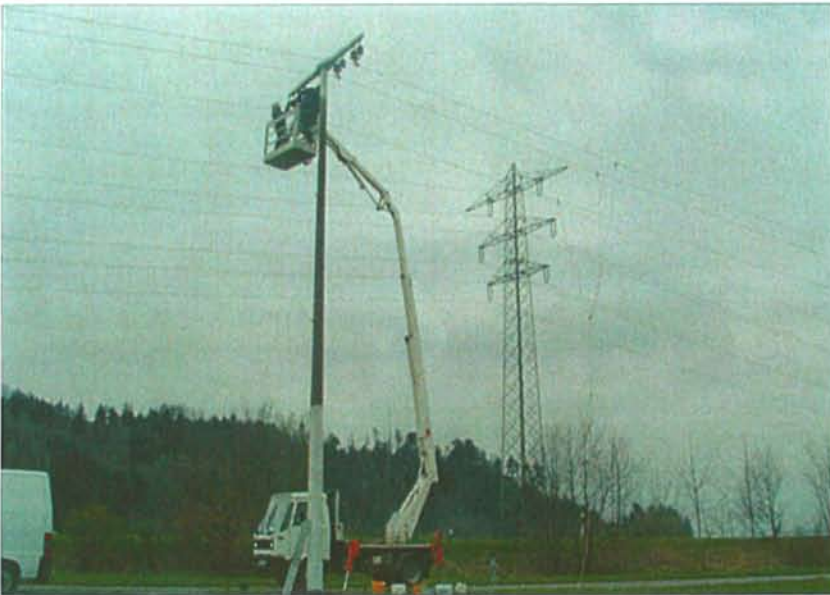
Bild 8: Beschichten der Betonmasten
