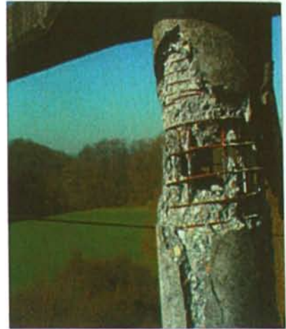
Bild 7: Schwere Torsionsschäden
