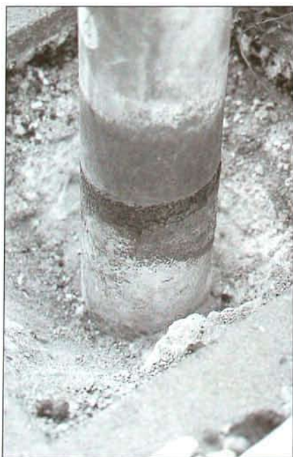
Bild 2: Zunächst wird der Mastfuß entrostet und anschließend die Mastdicke mittels Ultraschall ermittelt
