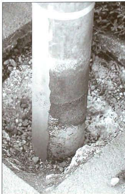
Bild 2: Zunächst wird der Mastfuß entrostet und anschließend die Mastdicke mittels Ultraschall ermittelt
