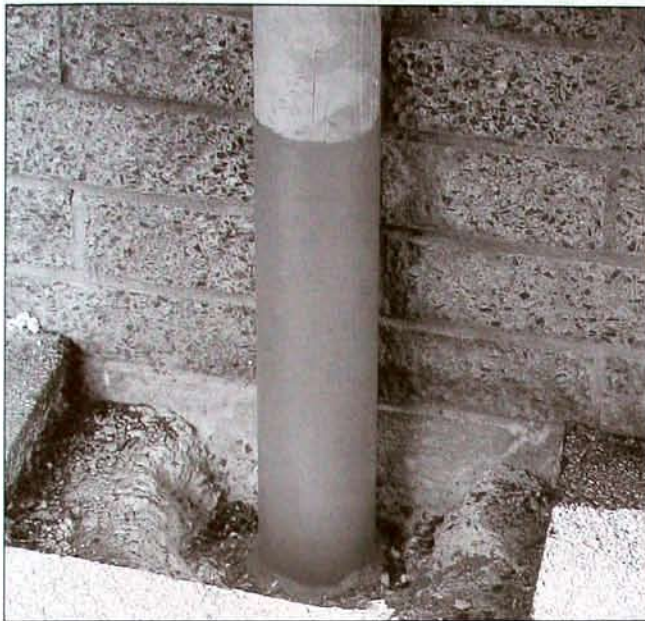
Bild 4: Fertig behandelter Mast
